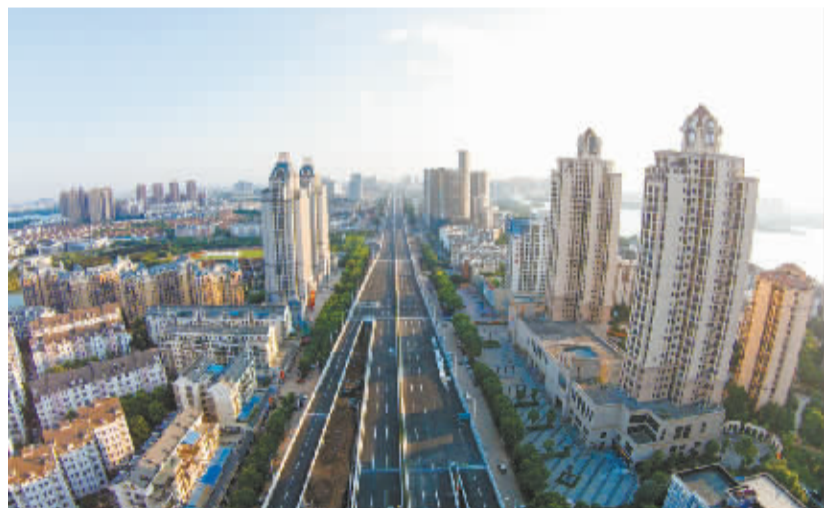
图为即将通车的东风大道高架桥。
