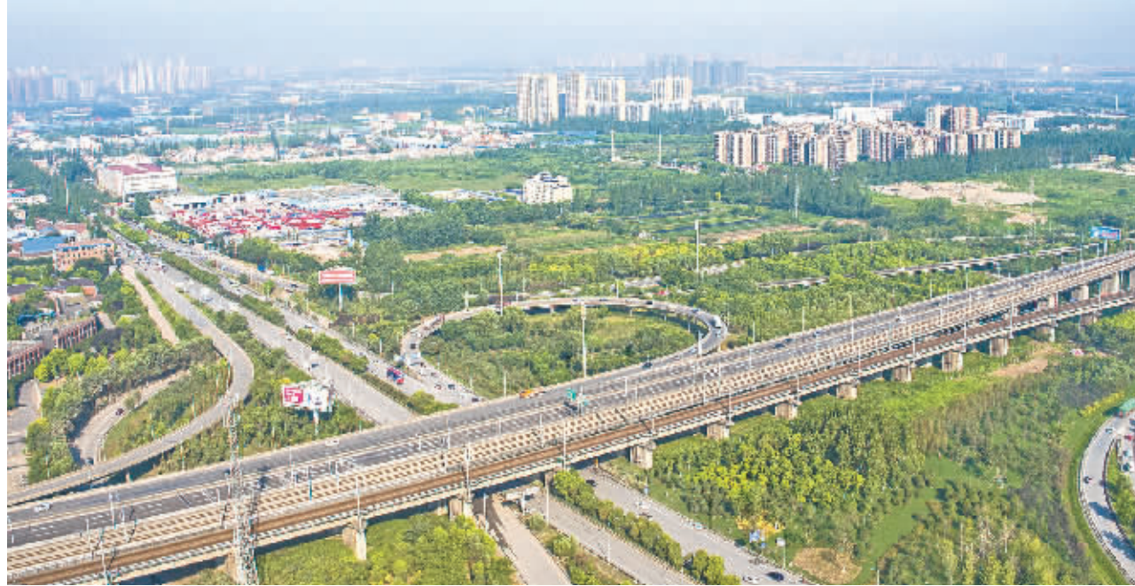
长江新城选址区域内的三环线平安铺立交
