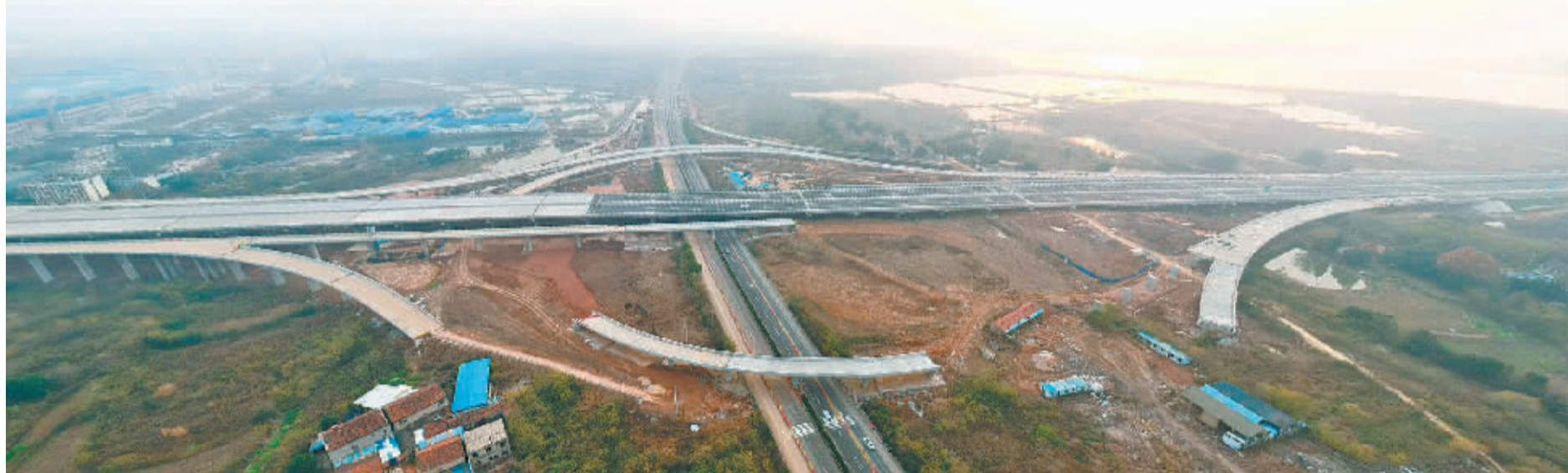
正在施工中的南四环龚家铺立交
