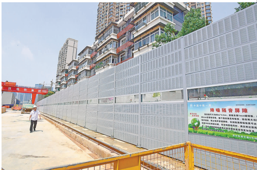
8月9日,施工单位在工地与居民小区之间安装隔音屏
