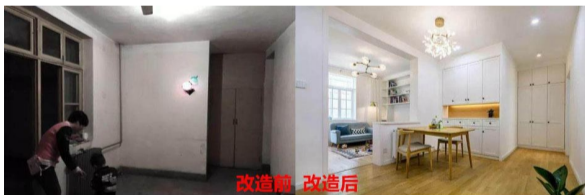
改造前:餐厅与客厅之间的窗户把空间分割后显得拥挤不通透,严重影响了采光,让用餐时的心情变得不美丽。 改造后:拆除客厅之间的窗户,不仅增强采光,同时又多了一个小吧台,很好的解决了收纳难题。
