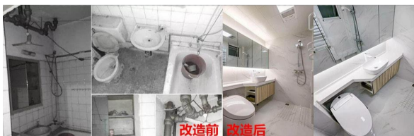
改造前:卫生间里裸露的水管,破旧的洗漱台、马桶,浴缸让狭小的卫生间显得更加狭小。 改造后:卫生间内一整面的橱柜和台面设计,可以从视觉上扩大卫生间,最大化的增加了卫生间内的收纳空间。
