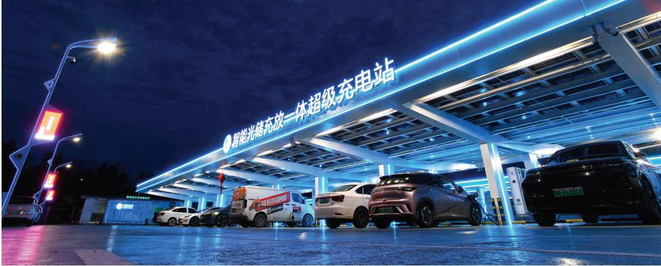
南太子湖超级充换电服务中心面积约6200平方米,是我省首座配备液冷充电设备的“光储充换放”一体超级充电站。
