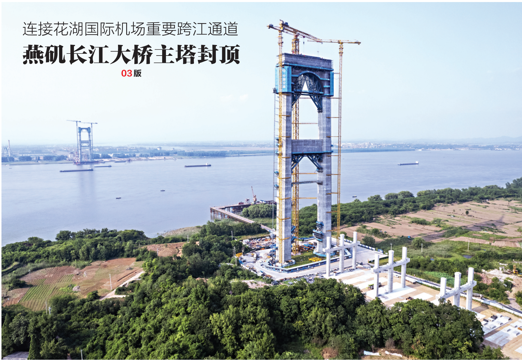
燕矶长江大桥鄂州侧主塔封顶。
