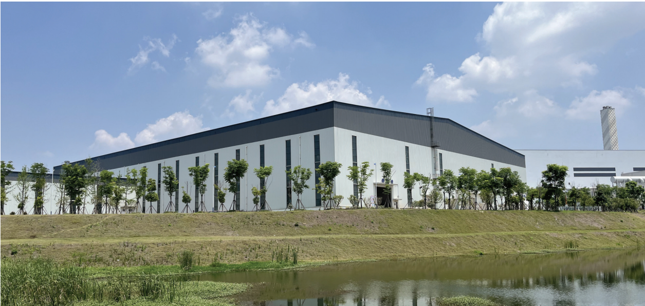
武汉千子山循环经济产业园建筑垃圾资源化项目今年1月建成投用以来,累计产出环保砂近6万吨。 记者宋磊 摄
