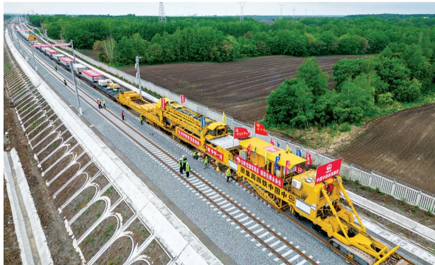
据新华社电 记者从中国铁路哈尔滨局集团有限公司获悉,28日,在黑龙江省铁力市哈伊高铁铁力至伊春段铺轨施工现场,随着首对500米长钢轨铺设在有砟轨道道床上,标志着我国在建最北端高铁哈伊高铁正式进入铺轨施工阶段,为后续全线贯通奠定坚实基础(左图)。
