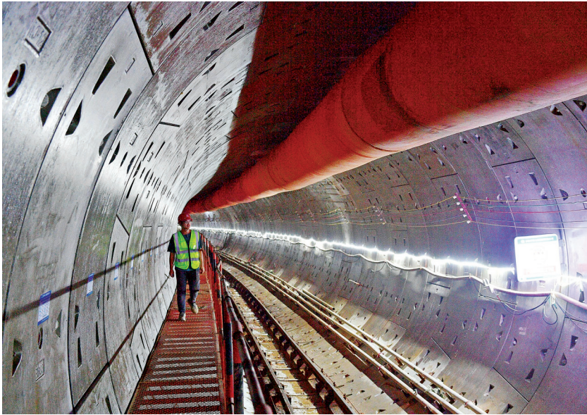
地铁12号线丁家咀站至十里铺站区间右线穿越硬岩段隧道内部。 李永刚 摄
