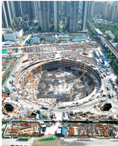
武汉周大福金融中心项目施工现场。
