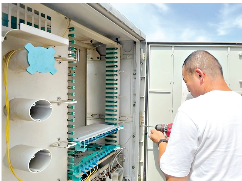
维修人员现场对光交箱进行修复。
