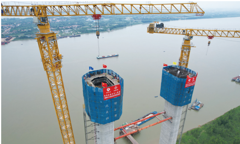
双柳长江大桥北岸主塔封顶。
