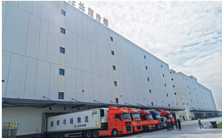
金控长贸国际冷链物流园3号冷库。
