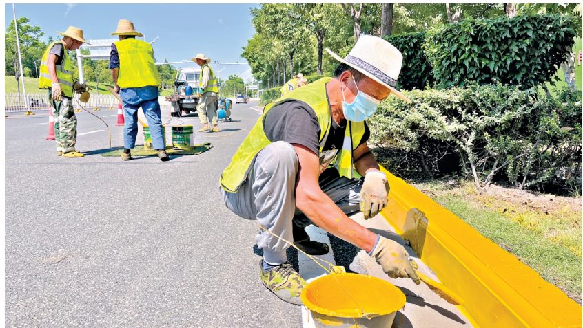
施工人员为青山区临江大道绿化带路缘石补刷油漆。 记者宋磊 摄
