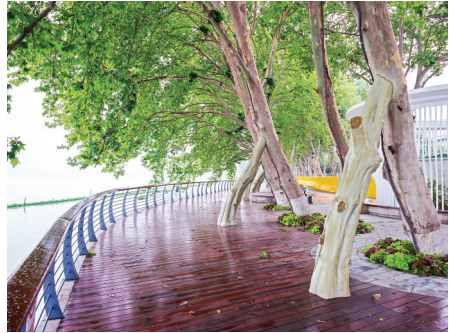
为自然倾斜的大树安装了金属支撑架,这些支撑架还做了仿法桐枝干的“美容”。
