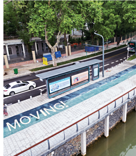
凌波门处拆除水马后的骑行道与人行道。
