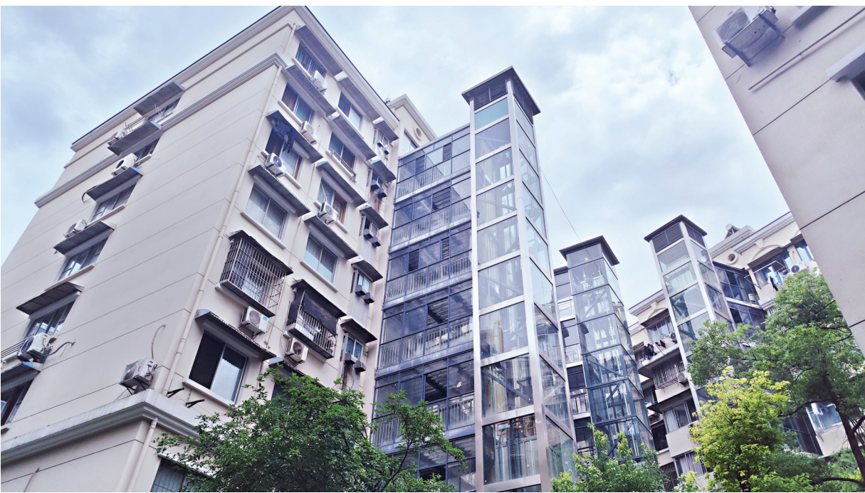
安友花园小区加装的电梯。
