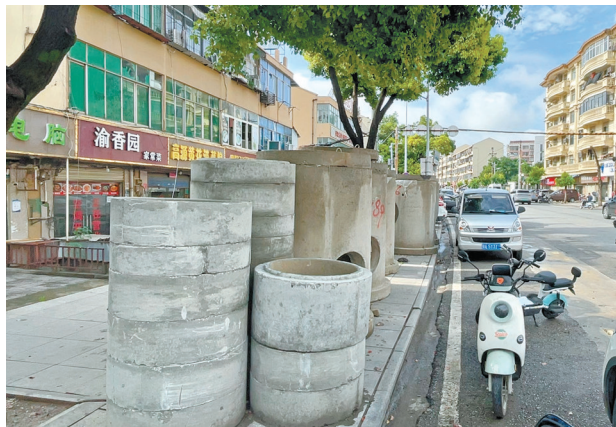
滠阳大街路口因施工改造摆放了一批2米多高的巨型水泥管。 记者尹勤兵 摄
