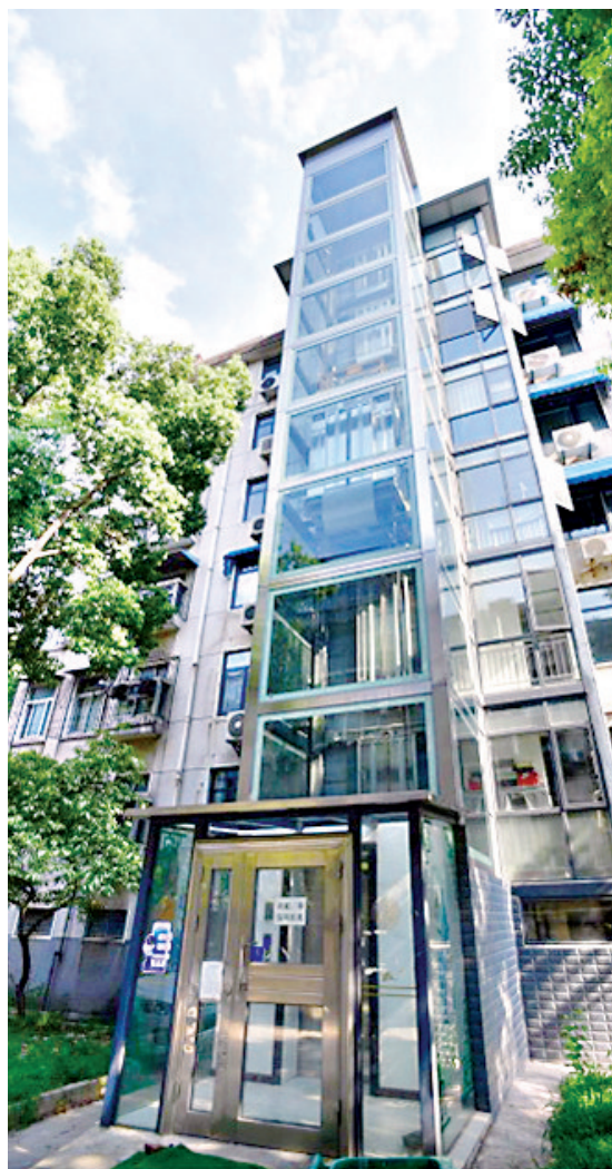
武昌区杨园街理工大水运社区加装的电梯。 李永刚 摄
