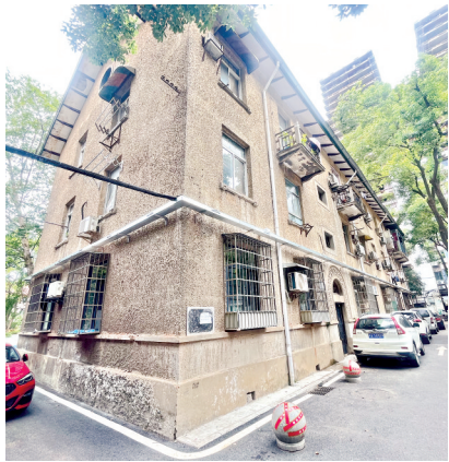
△老房子的建筑外观和工艺得以保留,但采用新式管道对各种杂乱的管线进行了规整。
