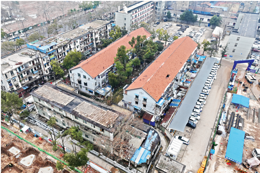
二十一街坊3栋房屋经第三方房屋安全鉴定机构鉴定,安全等级均为C级。 新沟桥街道供图
