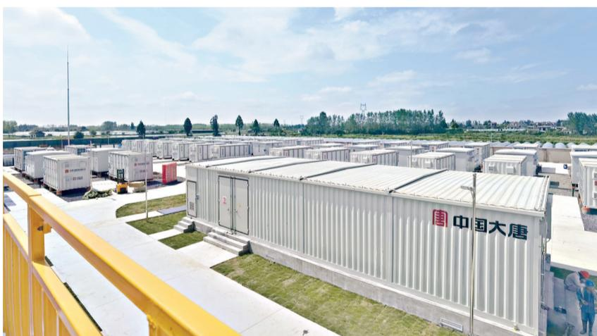
大唐湖北储能电站项目共有21组储电单元,最多可以存储10万度电。
