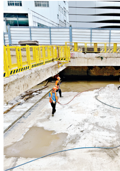
在秦园路站,施工人员用空压机除尘枪清理顶板杂物灰尘。 记者陶常宁 摄
