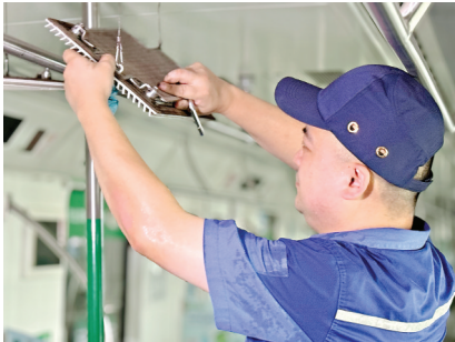
地铁列车检修人员检查空调新风口滤网,衣服湿透。 记者陶常宁 摄
