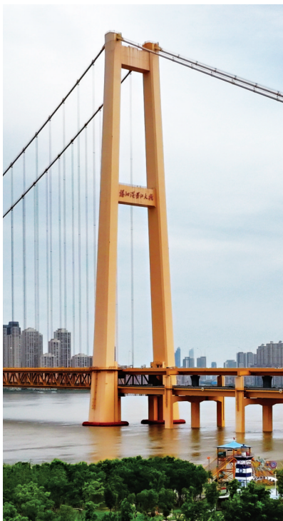
杨泗港长江大桥。
