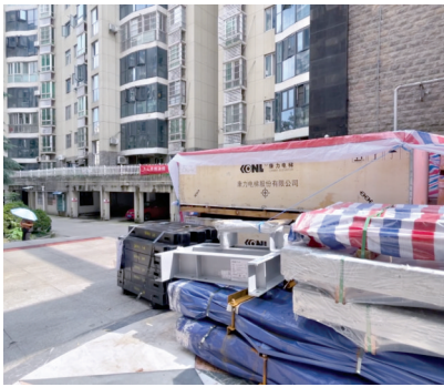
7月2日,安装电梯之前,一些电梯部件被运抵小区。 记者杨荣峰 摄
