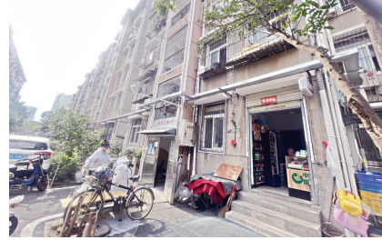
小区杂乱的线路被“装”进管道进行规整,还安装了智能摄像头。
