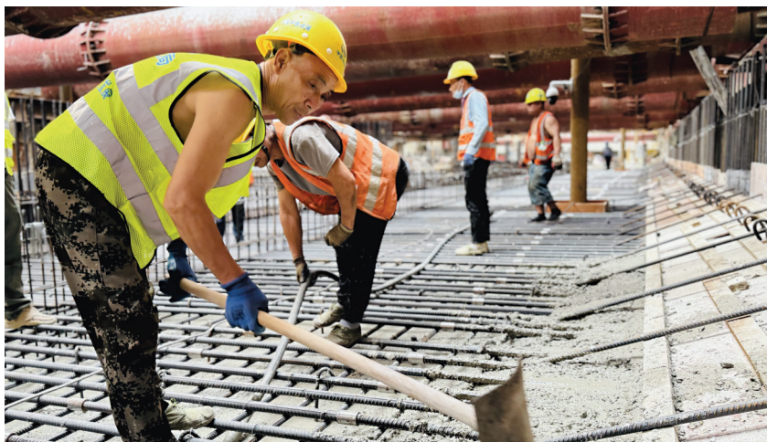
12号线双墩站基坑底部,正在浇筑最后一方混凝土。
