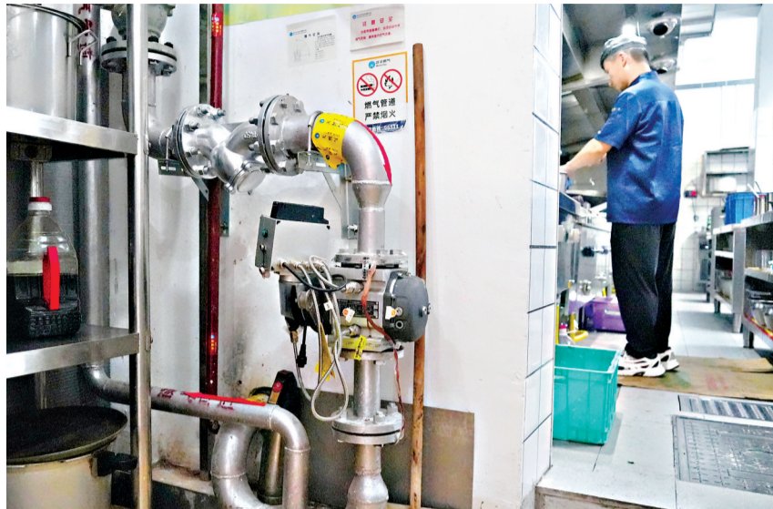
户部巷首批“瓶改管”商户已经用上了管道天然气。
