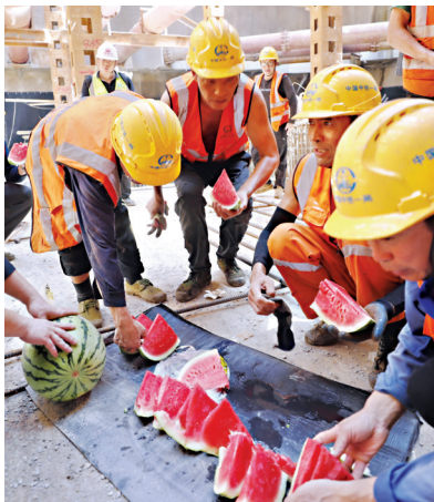
施工人员吃西瓜解暑。通讯员袁永华 摄 时间紧、任务重。针对高温天气,专门安排管理人员在现场及时关注作业人员状态,防范中暑等情况发生。
