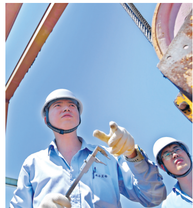
市特检所检验员在21米高空处为露天起重机“体检”。 刘斌 摄 武汉晚报讯 7月22日上午,在中建钢构武汉有限公司,武汉市特检所检验员丁锐、黄志威、陈剑在距离地面21米高空处,为露天总装线的一台通用门式起重机定期检验,“为设备‘体
