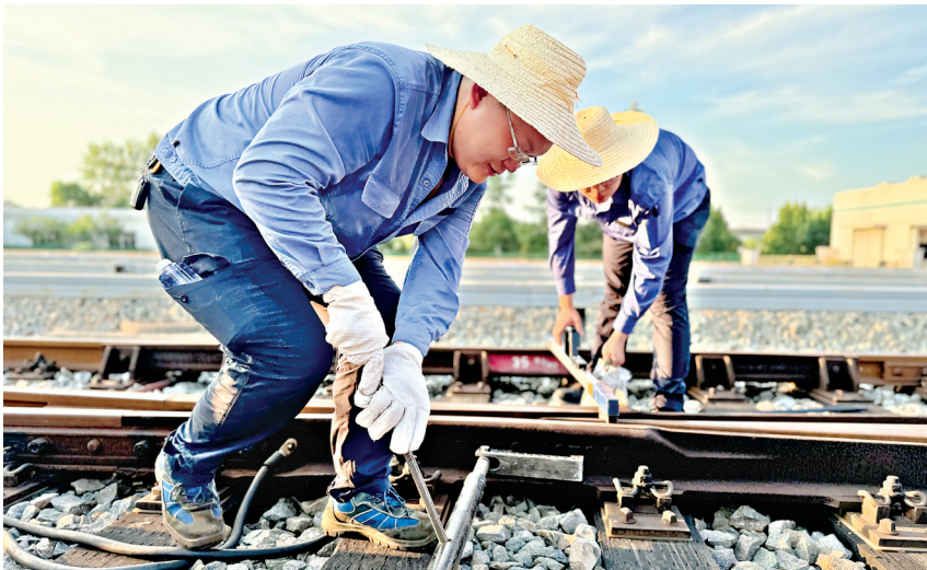
检修工调整道岔轨距。记者陶常宁 摄
