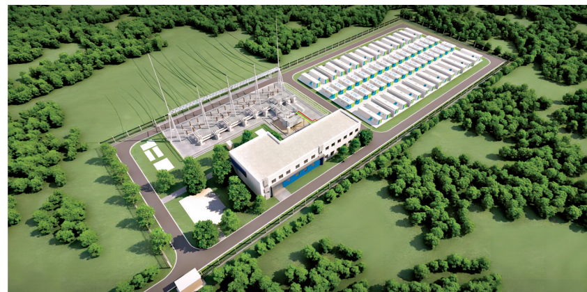
翼城县储能电站项目效果图。
