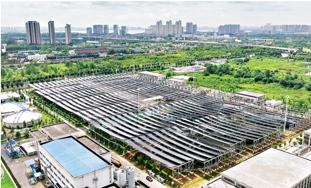
光伏发电项目。
