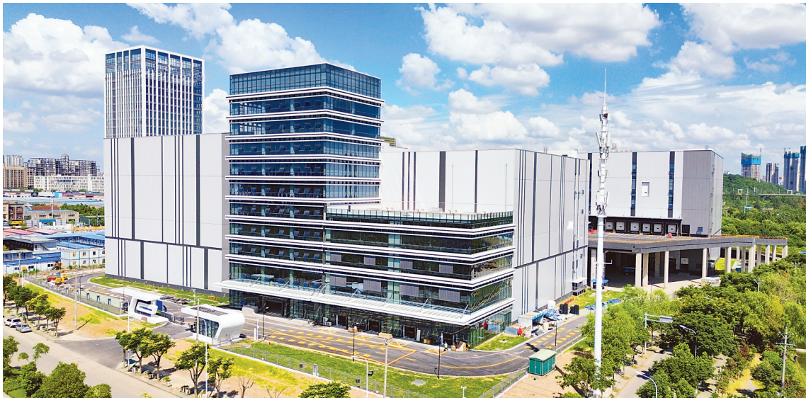
武汉主城区规模最大的冷链仓储项目。
