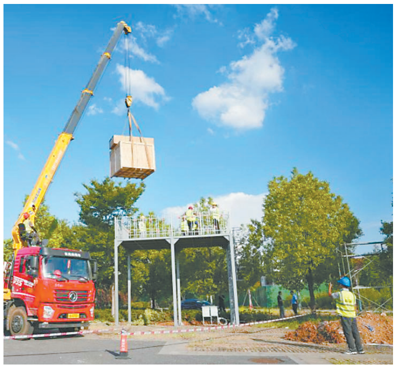
在新月溪公园的机库部署现场,工程师们和施工人员顶着烈日作业。
