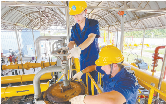
运维工正在检修天然气过滤器。
