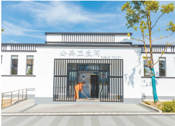
武汉市首座“城市驿站+智慧公厕”综合体。
