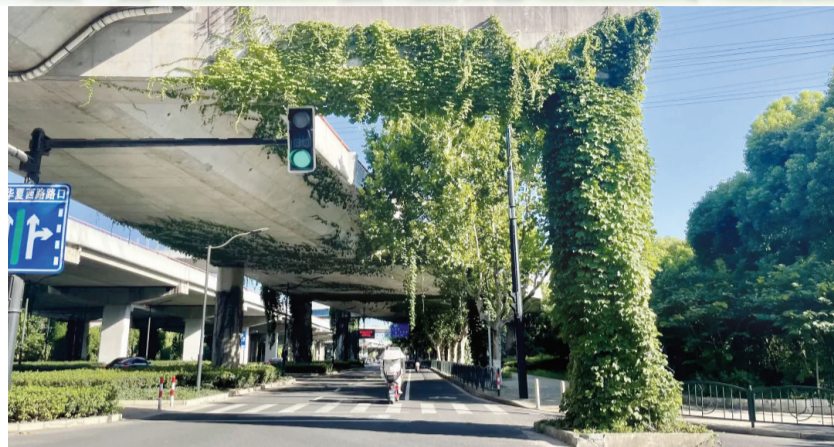
高架桥下的爬山虎墙。
