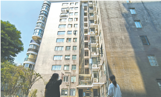
D栋外墙维修项目完工。
