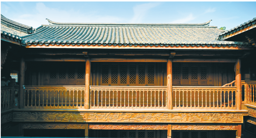
8月21日在卧龙古渔村拍摄的一处经修复的历史风貌建筑。
