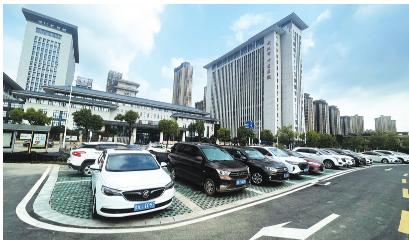
近日,武汉市中医医院汉阳院区对面建成新的停车场。
