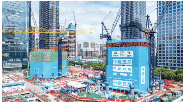
正在建设中的深圳湾某项目。
