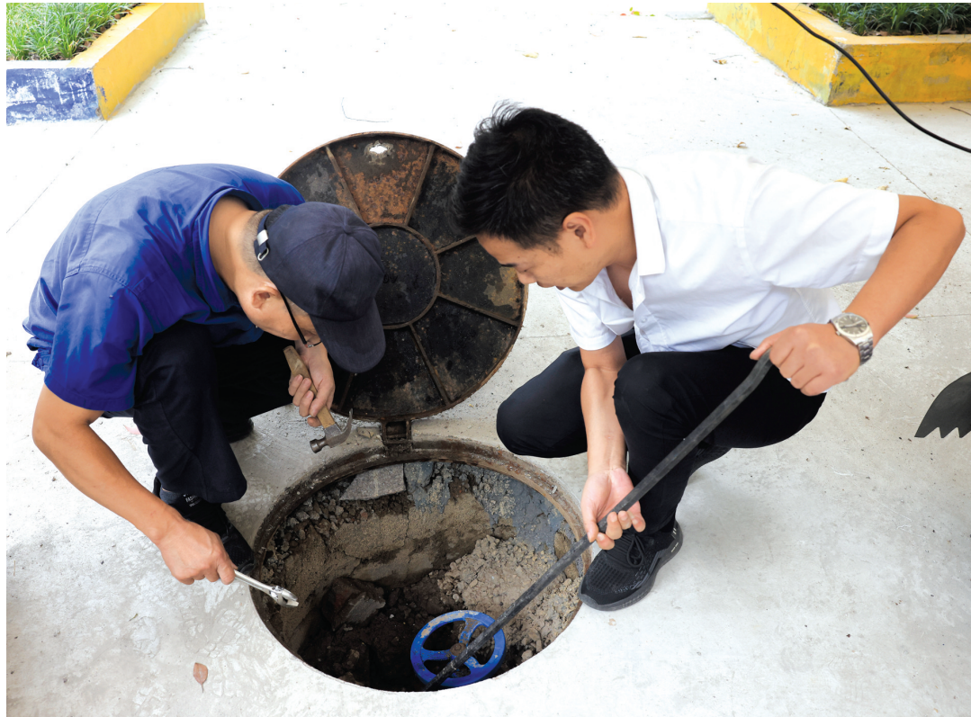
9月21日,物业人员察看之前修好的24栋总水管阀门状况。
