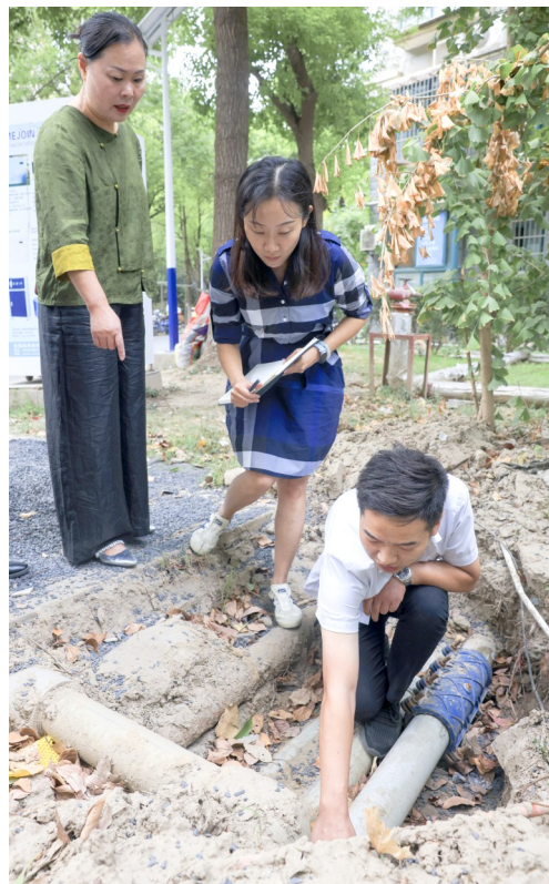
韩晶(中)和胡丽萍(左)、物业人员察看新漏点,商讨维修更换方案。
