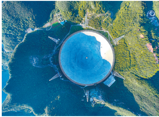
左图:这是9月25日拍摄的FAST核心阵试验样机开工奠基仪式现场(无人机照片)。新华社发
