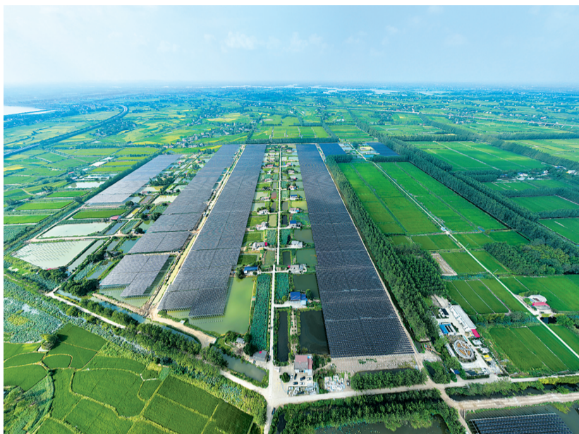
塌西湖光伏项目。
