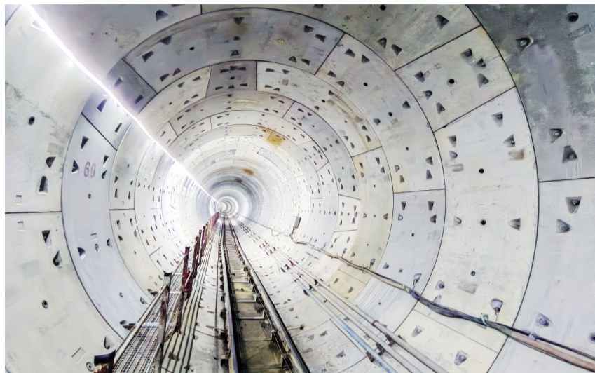
新港线一期工程万白区间成形,隧道干净整洁,管片光滑平顺。 通讯员袁永华 摄
