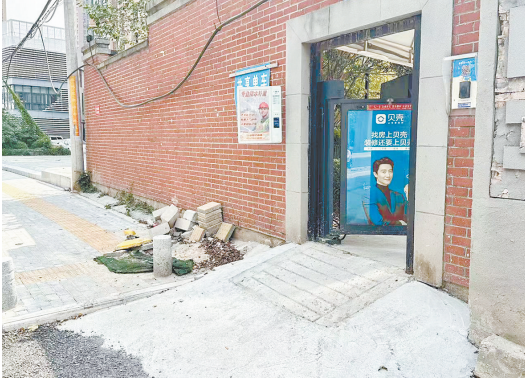
改造之后的坡道,居民进出没有障碍。
