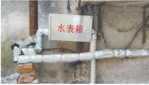
最后一截入水管做了防冻处理。
