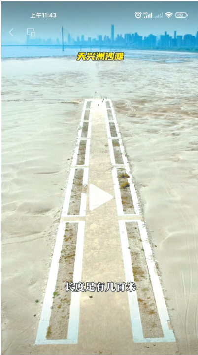
网友拍摄的天兴洲航道整治工程露出江面部分。 视频截图
