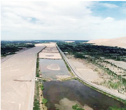
2021年7月5日拍摄的月牙泉补水工程的渗水场。
