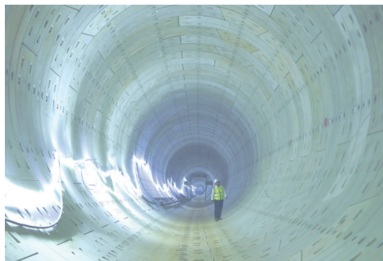
武汉地铁新港线一期工程万白区间隧道。
