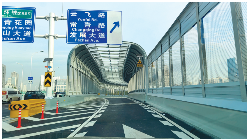
范湖立交改造工程下桥匝道。 记者詹松 摄
