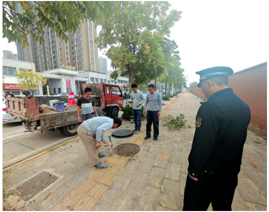
施工人员在现场更换新井盖。 记者商佩 摄
