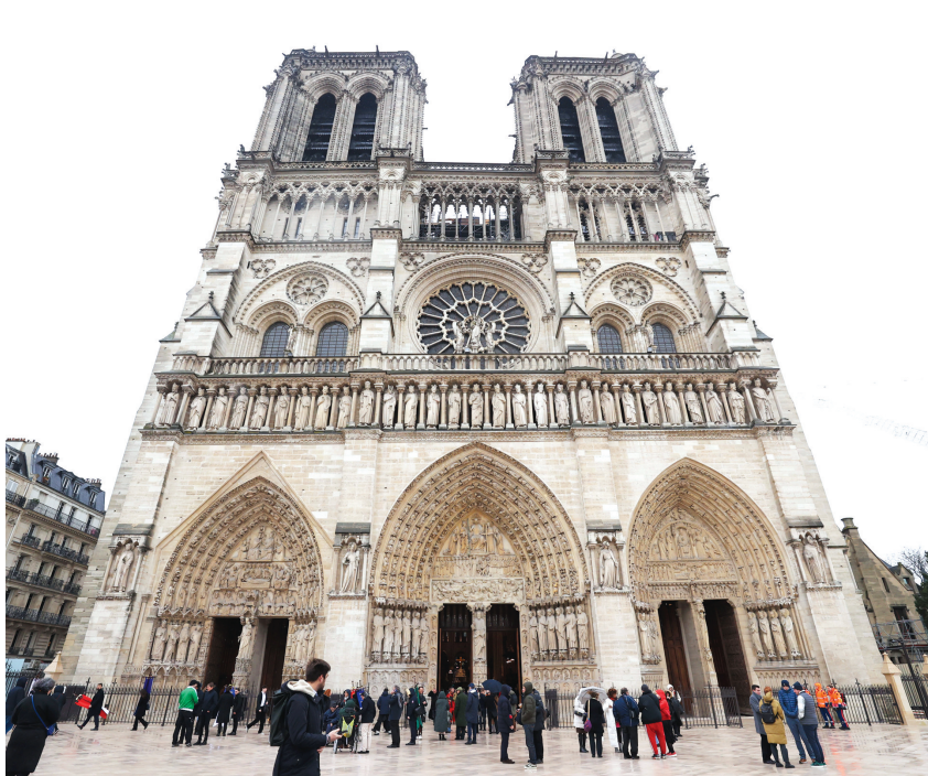
12月8日拍摄的巴黎圣母院外景。
